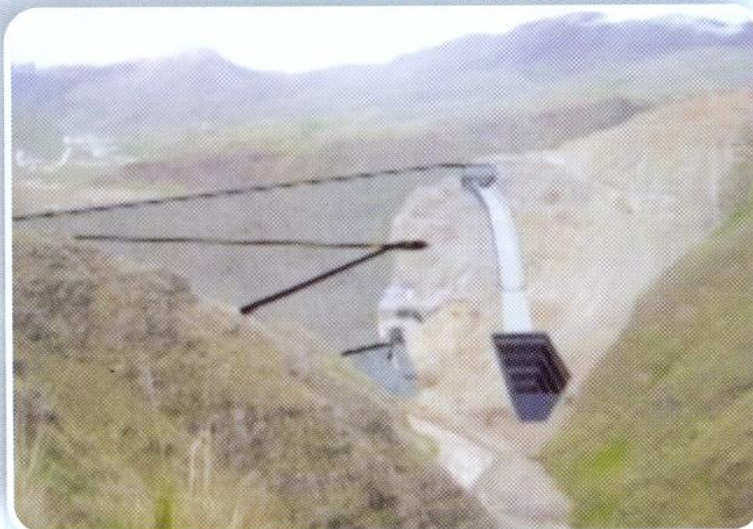
▶ TALUD AGUAS ABAJO
