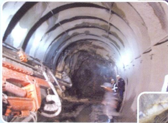
▲ PERFORACION JUMBO (TUNEL)
